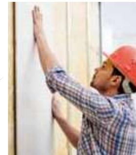
Una construcción de Drywall se compone de una estructura de metal galvanizado revestido con placas de yeso al interior y placas de fibrocemento al exterior.
