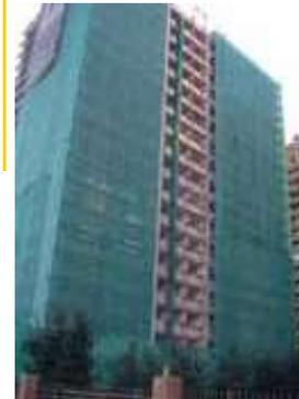
La Malla Raschel es una malla de fibra de polietileno de alta densidad (HDPE) que según el entretejido presenta diferentes densidades y resistencias a los rayos ultravioleta. Suele ser usado para el sombreado, delimitación, protección y techado de áreas.
